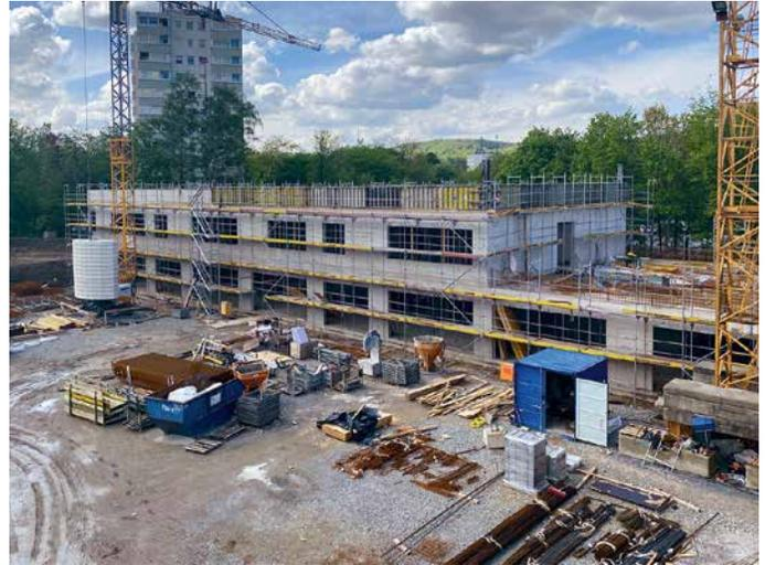
die Decken und Außenwände bestehen aus Stahlbeton. Im Erdgeschoss entstehen insgesamt zwölf Unterrichtsräume. Die Fach- und Nebenräume verteilen sich auf das Erdgeschoss und 1. Obergeschoss.
