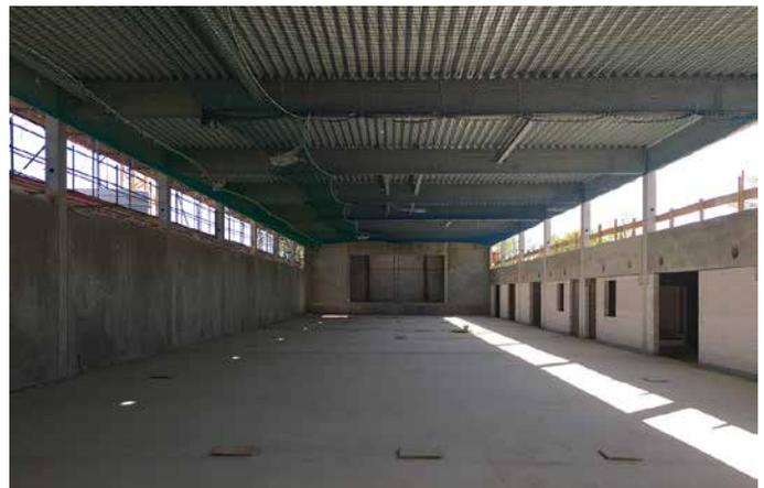
großen 2-fach Sporthalle entsteht zum größten Teil aus Stahlbetonfertigteilen. Nur die Nebenräume entstehen aus Ortbeton/ Mauerwerk. Die Sporthalle wird mit einer Blechfassade und einem Verblendmauerwerk verkleidet.
