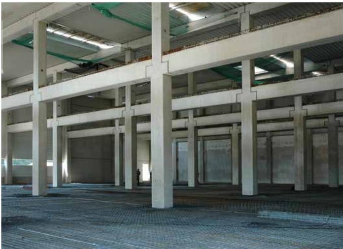
Die Modulatorhalle für das Deutsche Elektronen-Synchrotron (DESY) in Hamburg-Bahnhof sorgt für die Energieversorgung eines der spektakulärsten wissenschaftlichen Versuchszentren, einer Röntgen-Laseranlage. Die Halle wird mit in eigenem Werk der Baugesellschaft Sudbrack gefertigten Stahlbetonfertigteilen erbaut.
