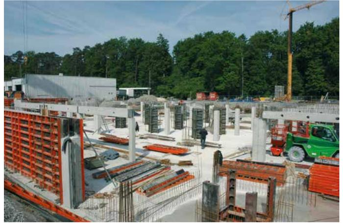
und 105.000 m<sup>3</sup> umbauten Raum. 500 Tonnen Stahl sind für das Bauwerk notwendig. Die Stahlbetonfertigteile sowie der Transportbeton werden vom firmeneigenen Sudbrackwerk geliefert, die Ortbetonarbeiten erledigen die Kollegen von der Hochbauabteilung.
