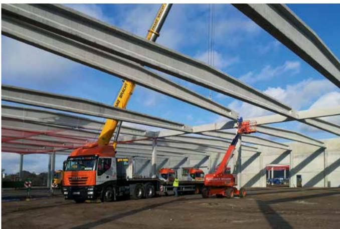
Baufirmen sind normalerweise Kunden von Baustoffhändlern. Aber: auch Baustoffhändler müssen mal bauen. Die Baugesellschaft Sudbrack baut für den Baustoffhändler Stelter und liefert jede Menge Beton. 2500 Fertigteile, insgesamt 295 Einzelteile, davon 45 Dachträger mit über 30 Metern Länge für 2 Hallen. Das dazugehörige Bürogebäude wird in Ortbetonbauweise gebaut, davon ein nicht unerheblicher Teil in Sichtbeton. Die Transportbeton Sudbrack mbH ist mit 4000 m<sup>3</sup> Beton beteiligt.
