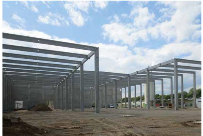
Gebäude, Sandwichfassade und FT-Gruben für die Verlade- rampen im Bereich der Anlieferung und eine Menge von Stahl- betonfertigteilen mit einem Gesamtgewicht von 10.000 Tonnen, die sich sehen lassen können: insgesamt 850 Einzelteile, davon 87 Spannbetonbinder und 150 Stützen mit Einzellängen bis 18,50 Meter. Das ganz große Paket wird zügig gepackt. Die Bauzeit beträgt 4 Monate, damit die vielen kleinen Pakete bald ihren Platz finden.
