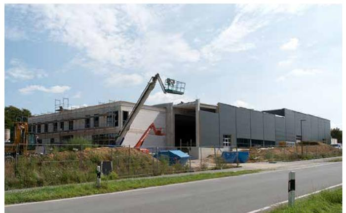
Sudbrack baut den Rohbau für eine Produktions- und Lagerhalle mit einer Fläche von ca. 3.300 m<sup>2</sup> und ein Verwaltungsgebäude mit einer Fläche von ca. 450 m<sup>2</sup>. In die Produktionshalle wurden Maschinenfundamente, Anliefer Rampen und -tore eingebaut.
